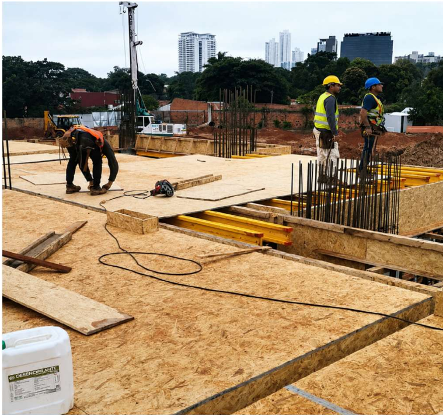
Trabajos de preparación de encofrado para cargamento de losa
