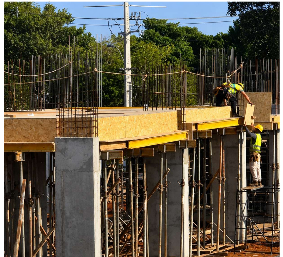
Trabajos de preparación de encofrado para cargamento de losa
